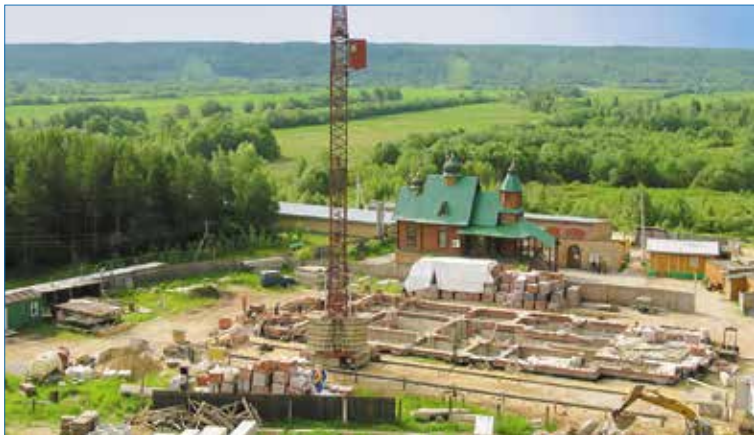
Начало строительства (2009 г.)
