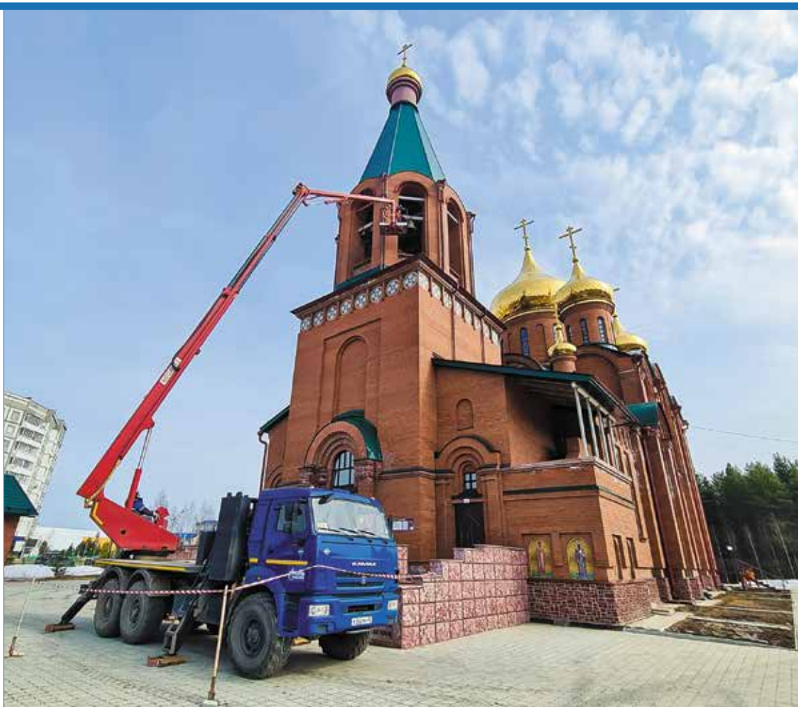
Силами специалистов ООО «Газпром трансгаз Ухта» на колокольне храма Новомучеников установлены элементы декора, а также проведен косметический ремонт
